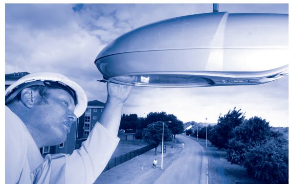
Vizion CMS Installation
